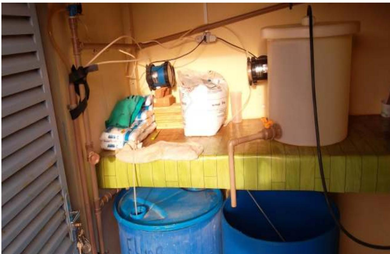
**IMAGEM 12: Junto à captação é realizado o tratamento da água com adição de flúossilicato de sódio e hipoclorito de sódio, estes através de bombas dosadoras que aplicam diretamente na rede.**
